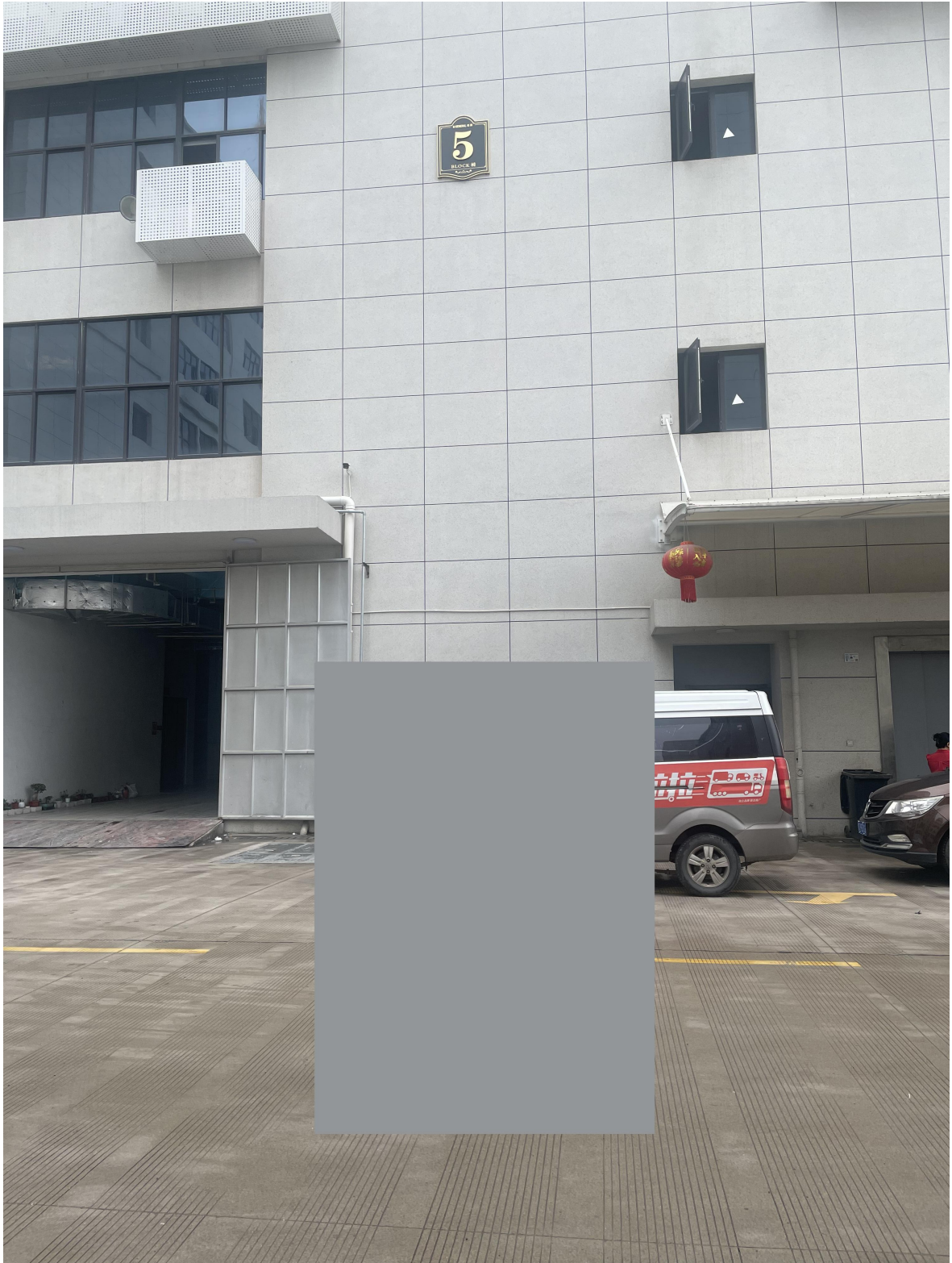
附图 1 编制主持人现场勘察照片
